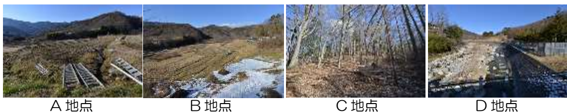
図-1 調査地全景および調査地点
