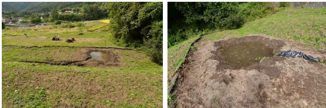
図-4. 施工後全景
